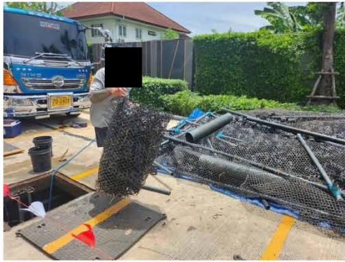
การสูบน้ำจากระบบบำบัดน้ำเสีย และการกันเขต
