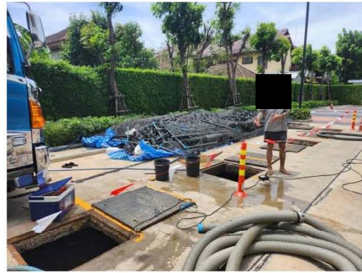
การสูบน้ำจากระบบบำบัดน้ำเสีย และการกันเขต
